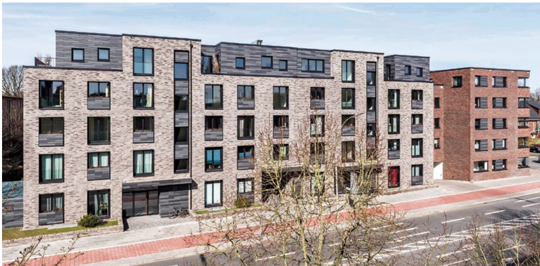
Fassade an der Julius-Brecht-Straße mit aufgesetzten Kubaturen im Staffelgeschoss
